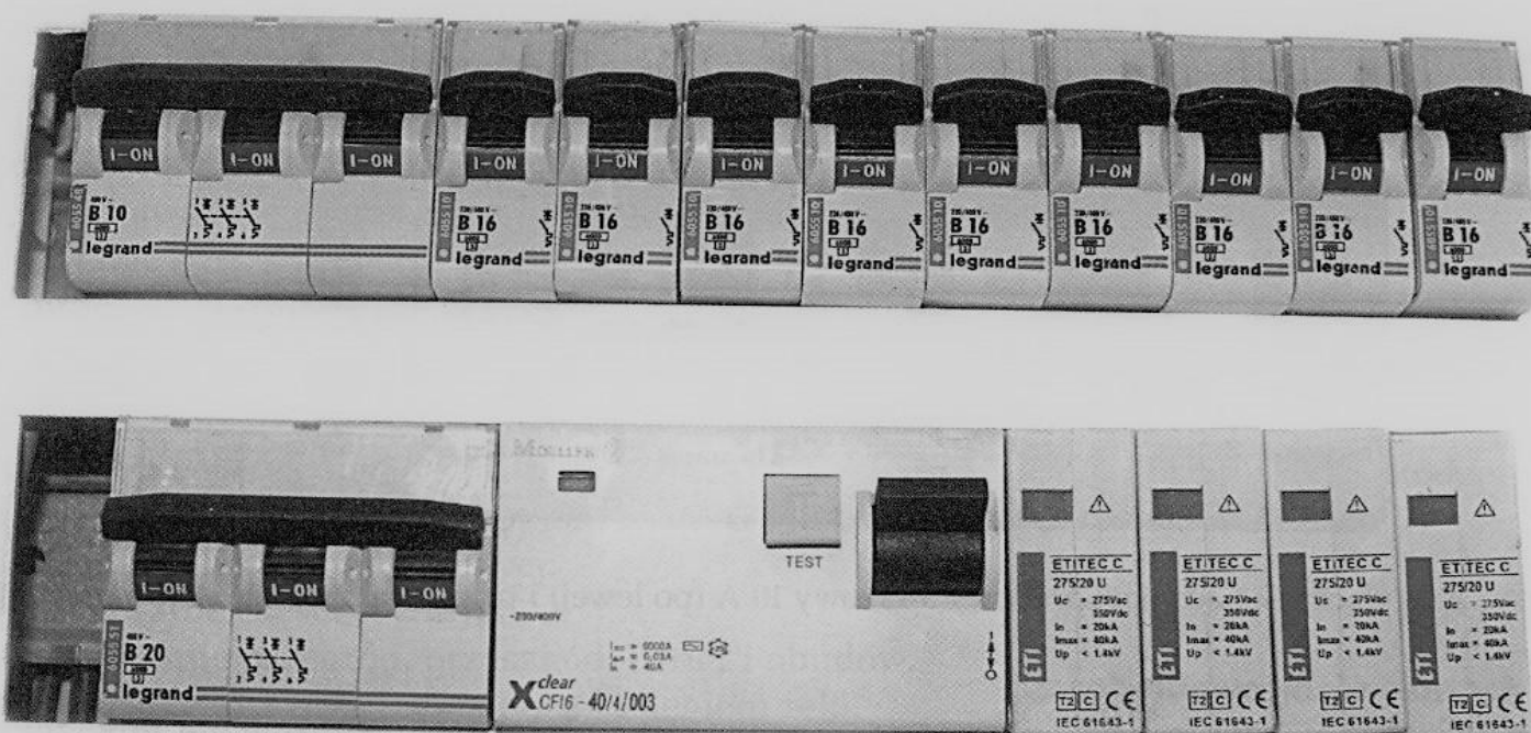
Rys. 8.2. Przykład prostej rozdzielnicy
